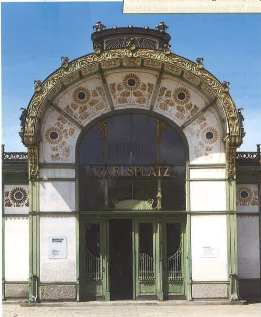
U-Bahn-Station Karlsplatz, Wien
